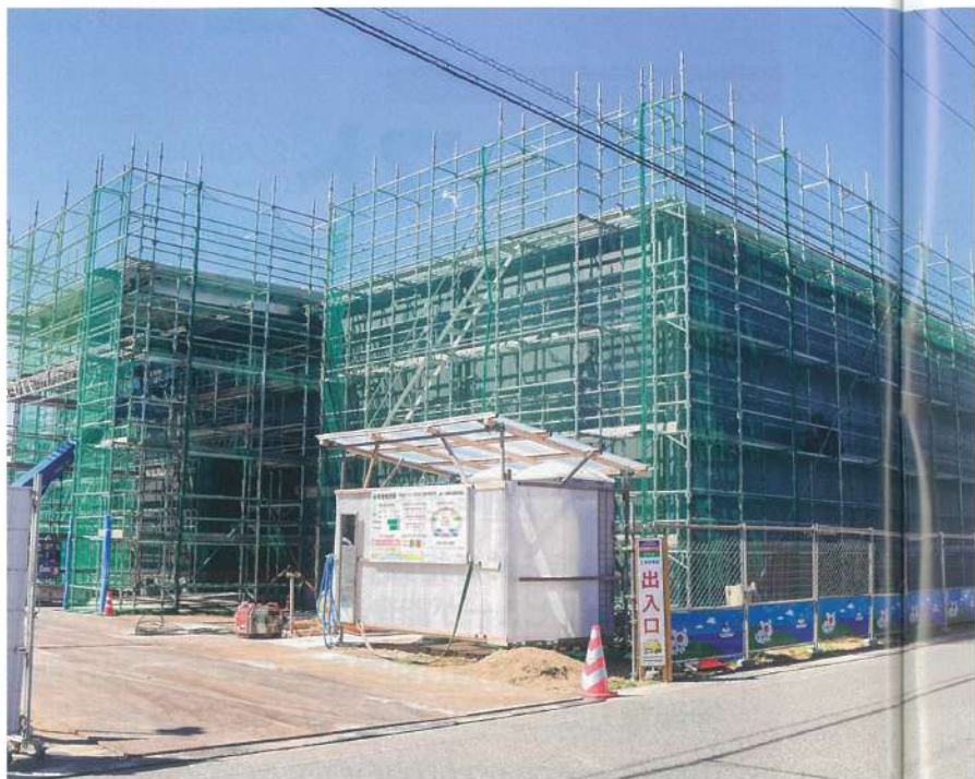
アイビーが建設中の新工場。拠点集約し、1.5〜2倍の生産能力増強を見込む＝松江市東出雲町意宇南2丁目
